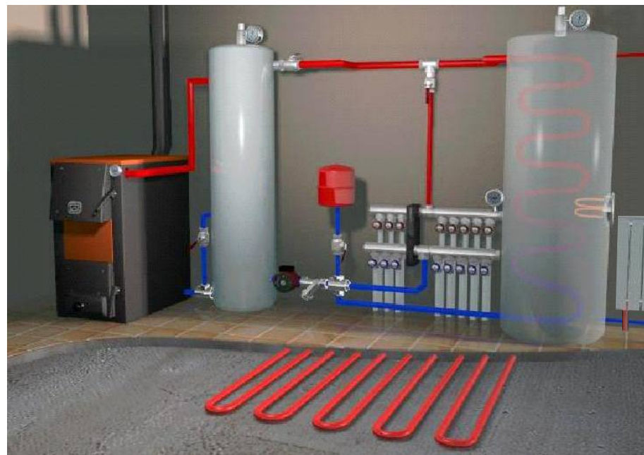
Котел «Куппер» с гидравлическим разделителем в закрытой малообъемной системе отопления. Современная система с коллекторной группой, радиаторами отопления, теплыми полами и бойлером косвенного нагрева для организации ГВС. Требуется подключение насоса для обеспечения циркуляции теплоносителя.
